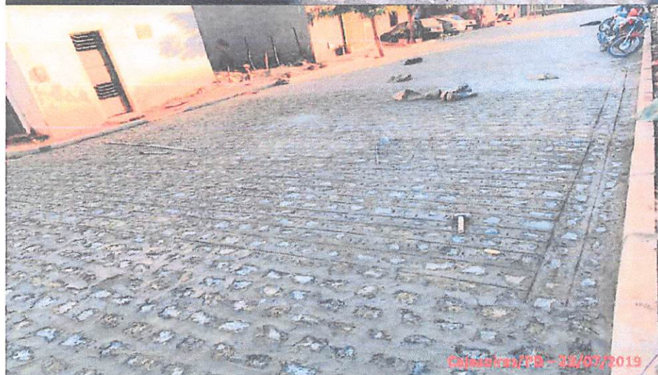
BM 04 - Contrato de Repasse 834700/2016 Ministério do Cidades – Implantação de Pavimentação em Vias Públicas Urbanas – Cajazeiras/PB (Rua João Bernardo de Oliveira – Pavimentação)
