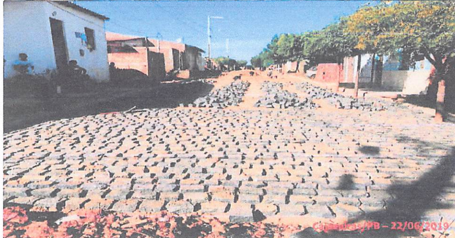
BM 04 - Contrato de Repasse 834700/2016 Ministério do Cidades – Implantação de Pavimentação em Vias Públicas Urbanas – Cajazeiras/PB (Rua João Bernardo de Oliveira – Pavimentação)
